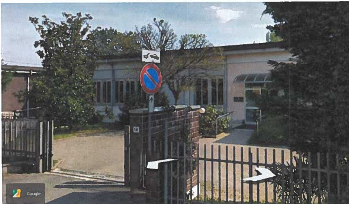
Immagine 9 – Facciata laterale lato ingresso CAL
