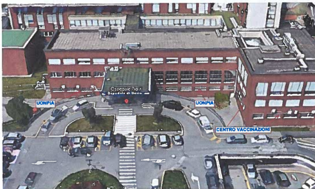
Immagine 11 – Vista frontale corpo D
