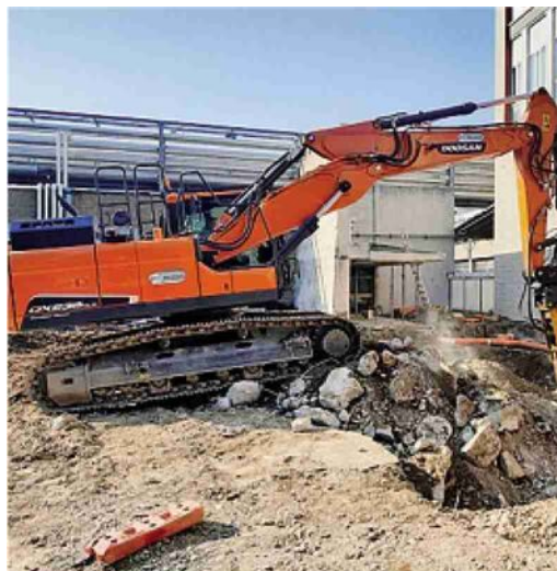
I lavori per la messa in sicurezza e impianto antincendio in ospedale Foto Farina
