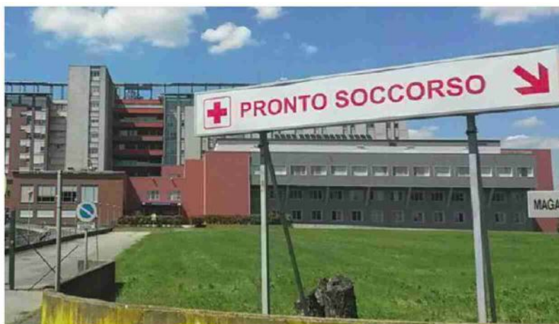
Al via nelle prossime settimane i lavori di ampliamento del Pronto soccorso
