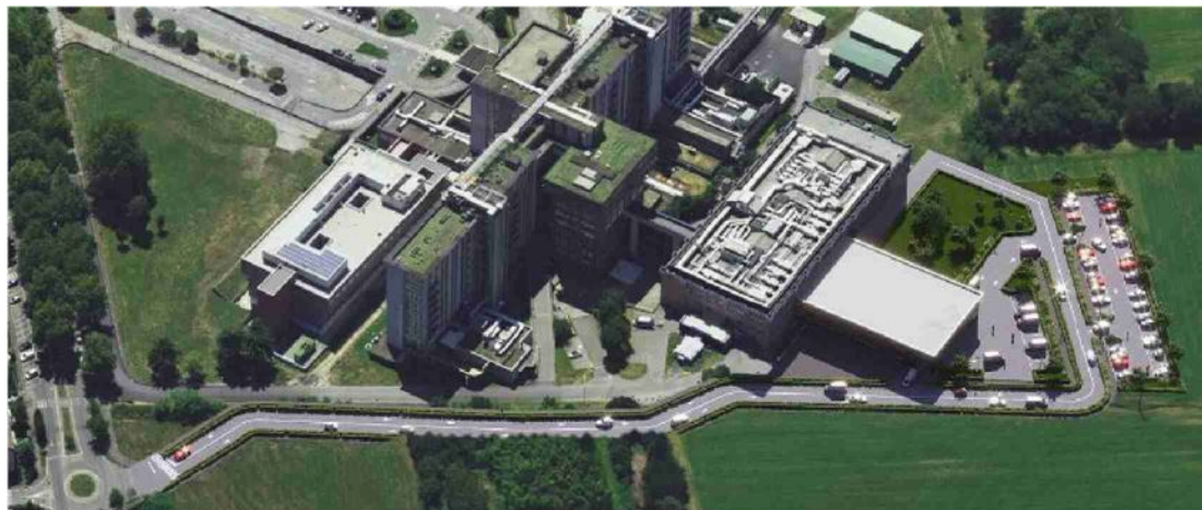
Il progetto con la modifica della viabilità e l'ampliamento del numero dei parcheggi nell'area del Pronto soccorso
